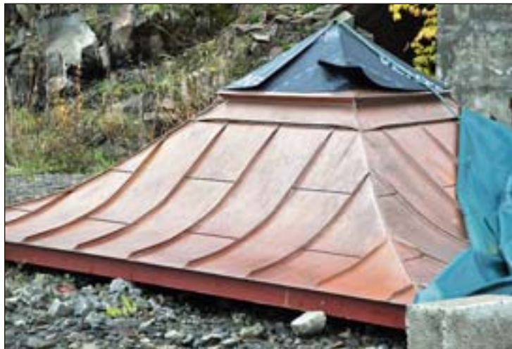
Kobbertaket er en kopi av det taket Bykiosken var utstyrt med i sin tid.
