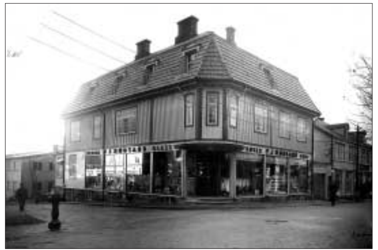
Bygningen slik den fremsto da Rødsand overtok den i 1958.
